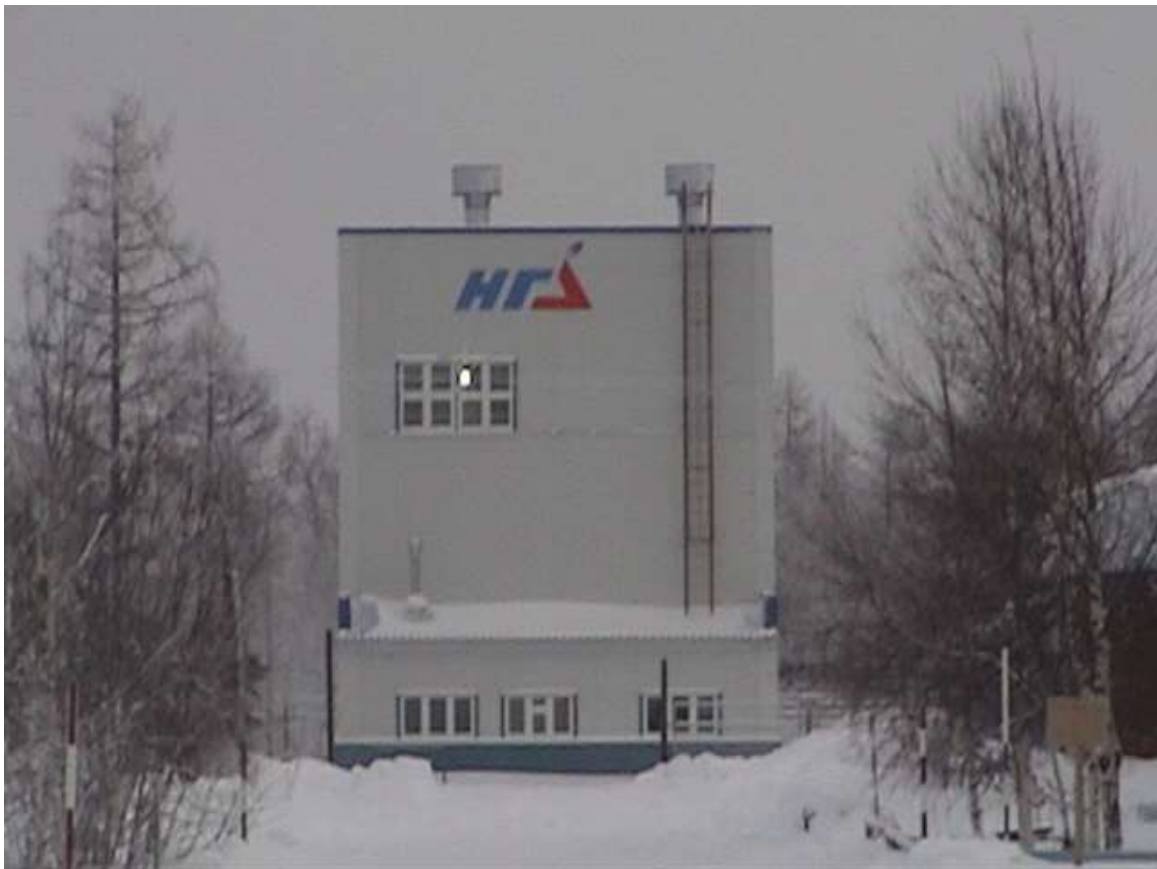
Установка работает по настоящее время.
