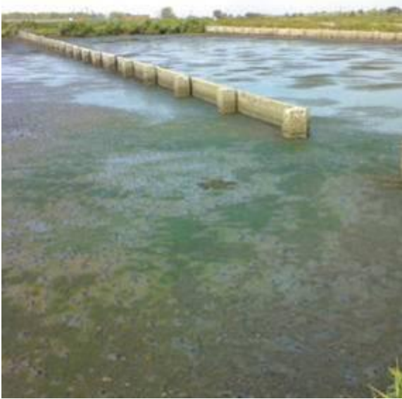
Рис. 1. Иловые карты с осадком влажностью 95-98%
